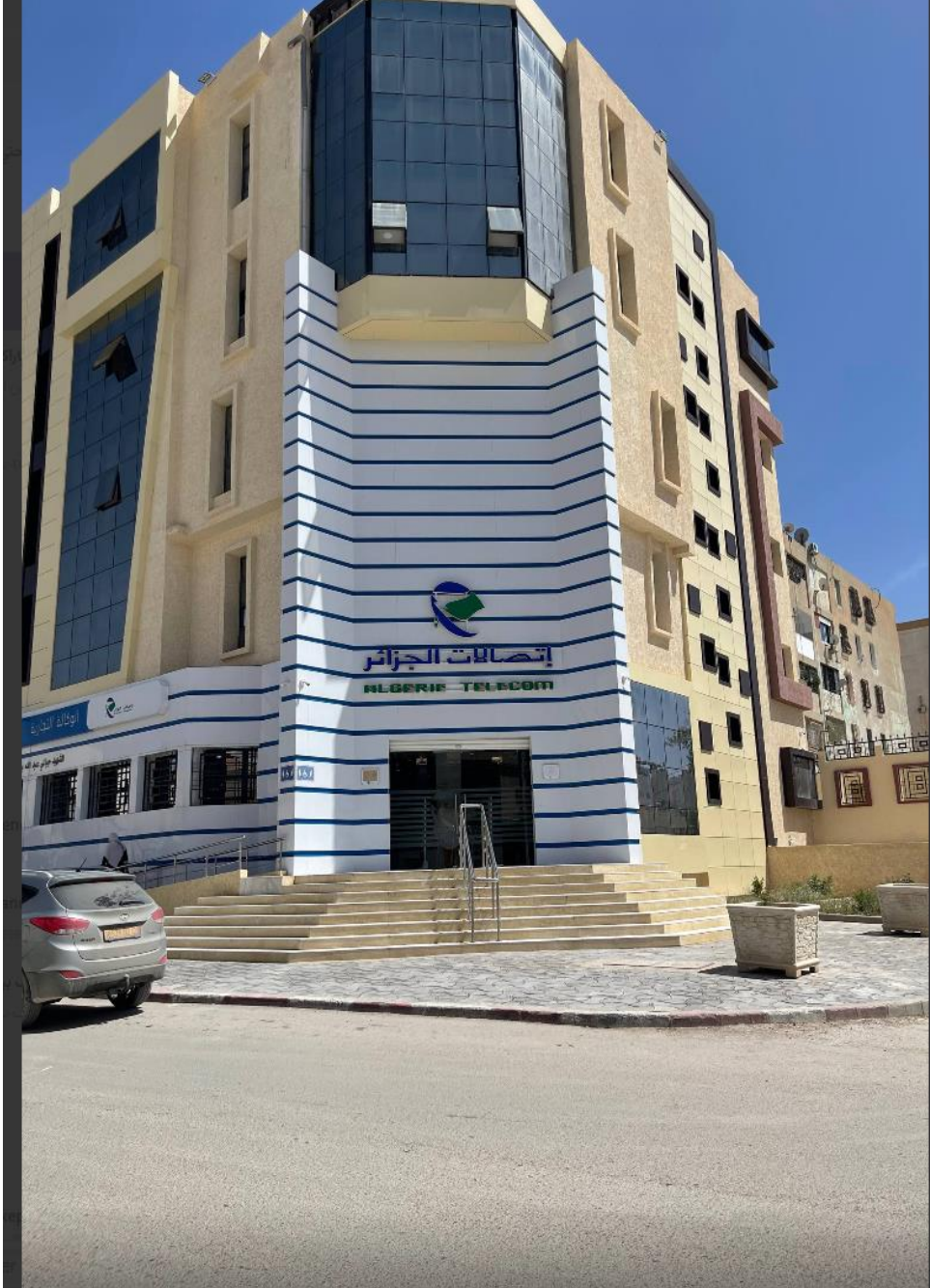
الملحق 03 : صورة مدخل مؤسسة اتصالات الجزائر فرع تبسة
